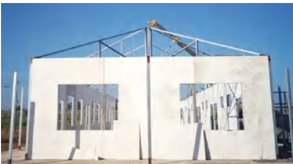
外墙板安装完成 Exterior Wall Panel Installation
